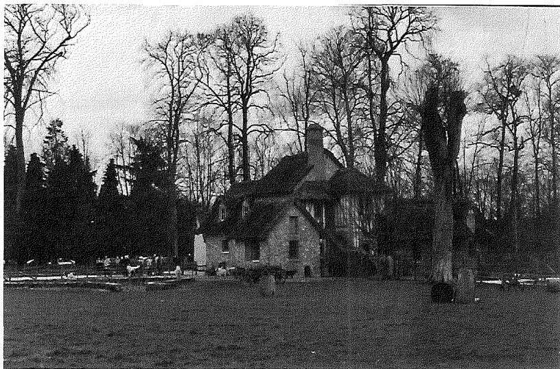
Abb. 4: Der bereits renovierte Bauernhof, 2002
