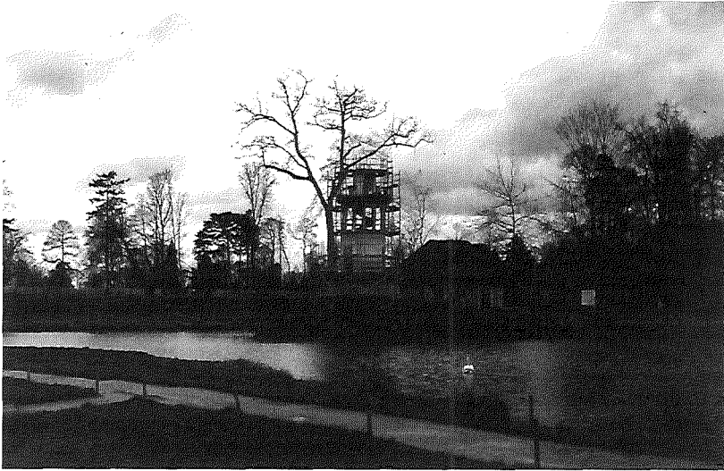
Abb. 5: Der Marborough-Turm im Baurüst, 2002 Foto: Nina Gorgus
