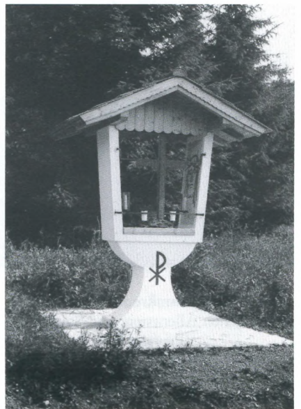
Abb. 96: Neuerrichteter Bildstock anstelle eines völlig zerstörten Bildstocks am Riemerhof (Privatarchiv)
