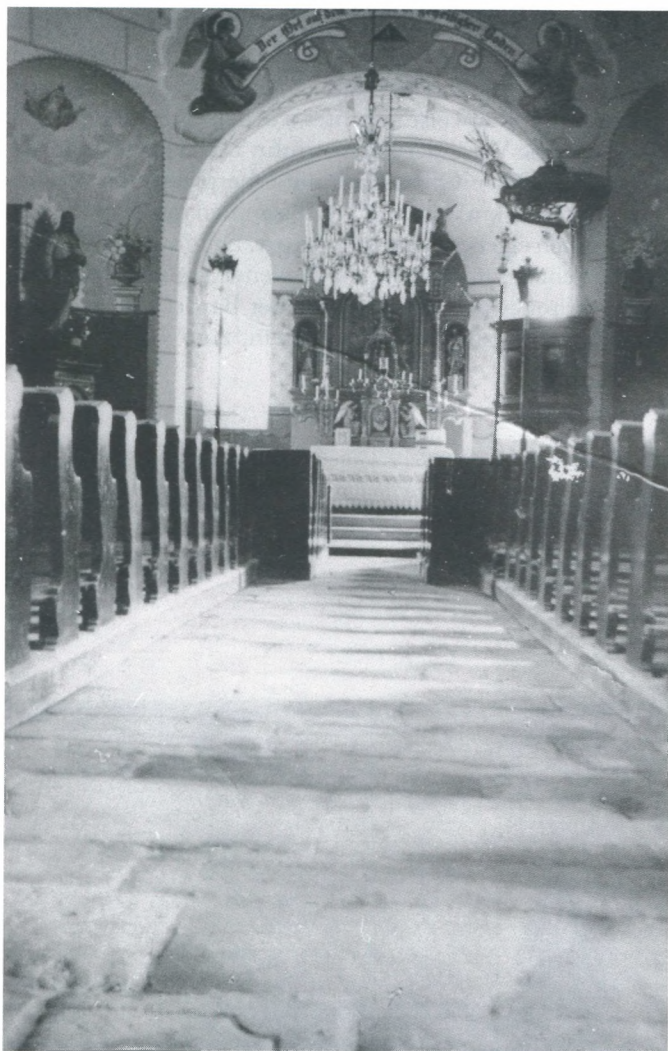
Abb. 71: Pfarrkirche von Oberndorf, Innenansicht (Privatarchiv)
