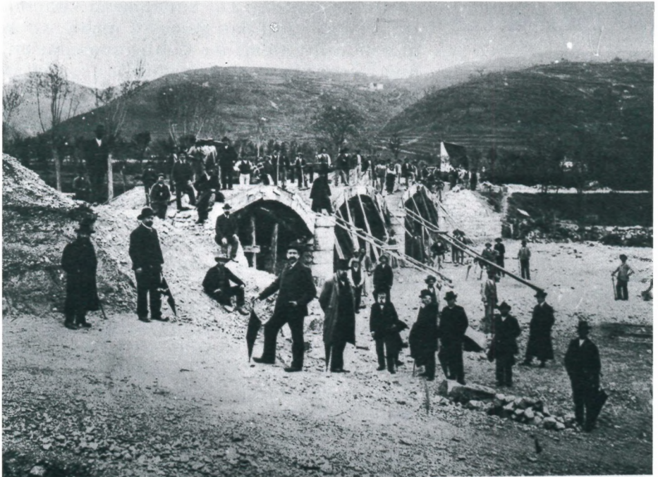
Brückenbau über den Progno in Tregnago
